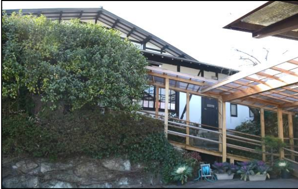
法人事務所・アトリエ玄関アプローチ
